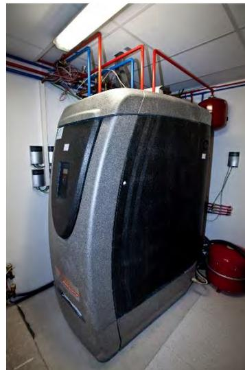
Fig. 6 SOLAR HEAT PUMP (SONNENKRAFT)
