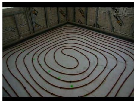
Fig. 5 GROUND HEATING SYSTEM (BEFORE CONCRETE SLAB)
