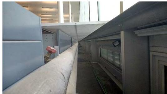
Fig. 5 UNDERFLOOR CONVECTOR HEATING SYSTEM
