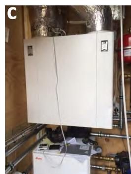
Fig.8a) EAST SIDE , B)ACCUMULATION TANK, C)AHU AND HEAT PUMP
