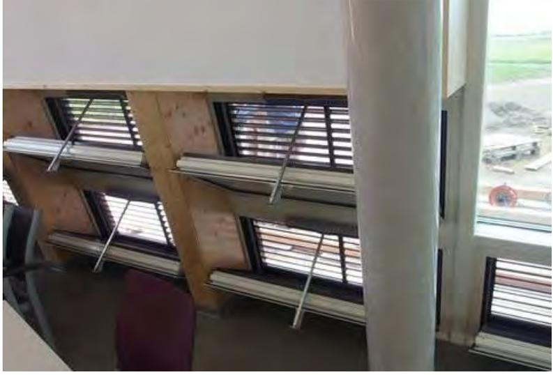
Fig. 10 BOTTOM-HUNG PROJECTING-IN OPENINGS, SOURCE: ARCHITEKTURBÜRO REINBERG ZTGMBH
