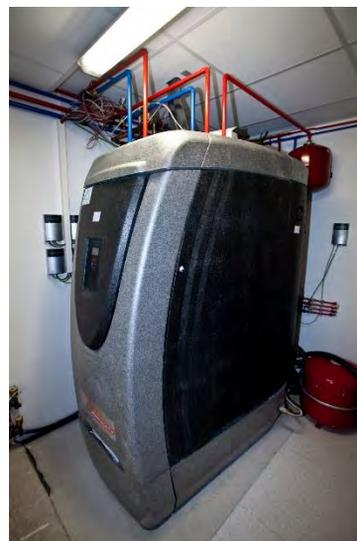
Fig. 6 SOLAR HEAT PUMP (SONNKRAFT)
