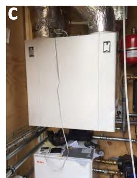
Fig.8a) EAST SIDE , B) ACCUMULATION TANK, C) AHU AND HEAT PUMP
